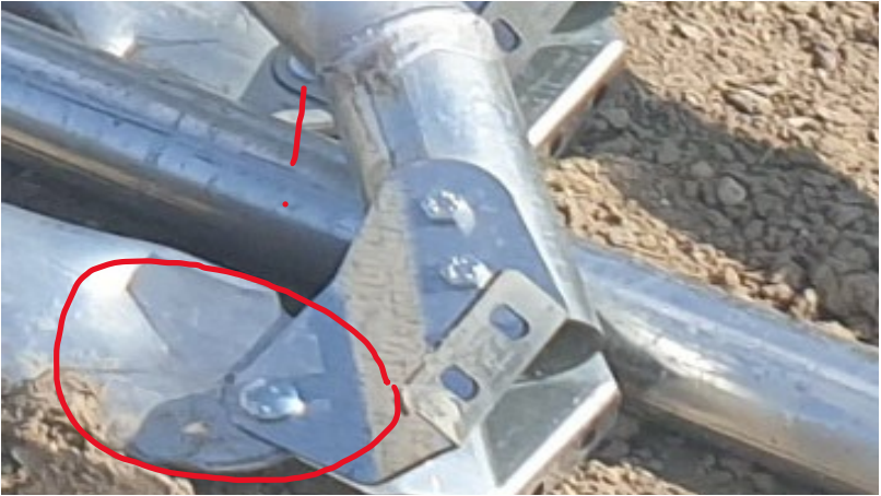
EZİLMİŞ ELEMAN VE 8 LİK CİVATA BİRLEŞİM
